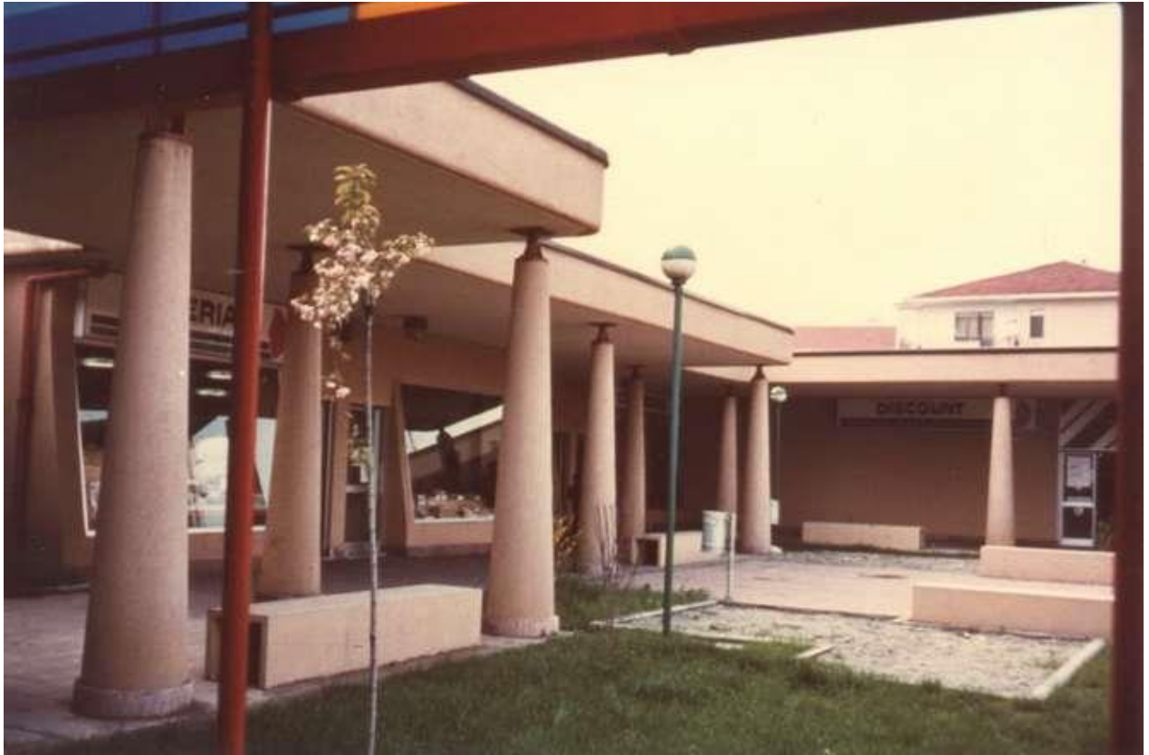
Strutture di centro commerciale a Settimo Torinese, INARCO Srl, 1977.
