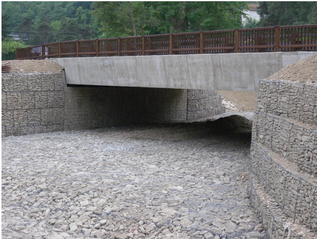
Ponte sul torrente Tatorba, Provincia di Asti, 2009.
